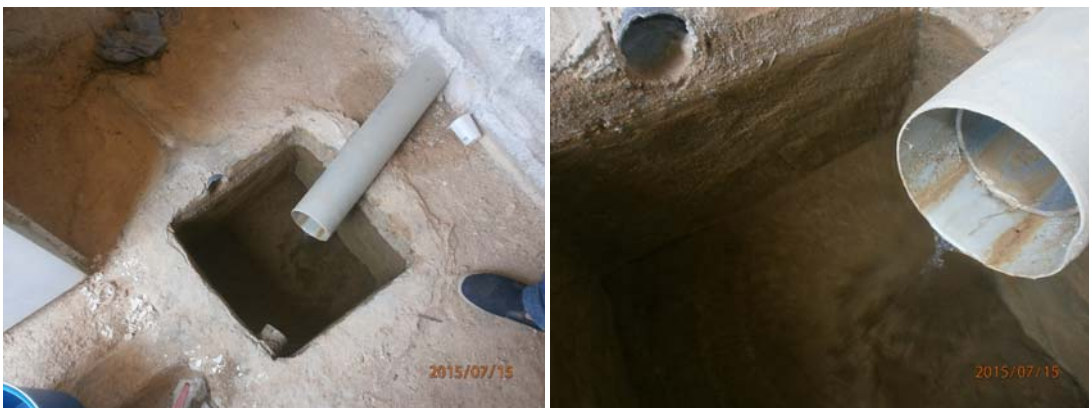
Manantial 2. Vista de la caseta exterior y vistas del interior de la caseta.
