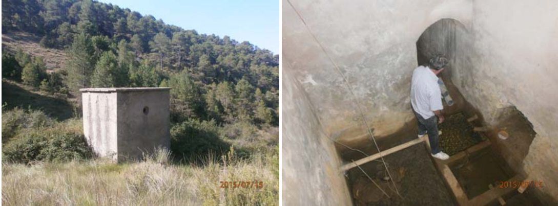
Manantial 1 "El Prado". Vista de la caseta exterior y vista del interior de la caseta.
